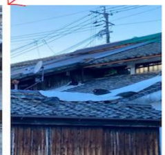
裏側からの写真(シートで瓦屋根を応急措置)
